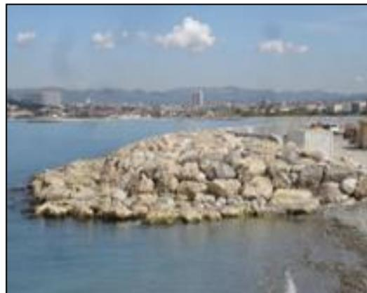
**Les enrochements** : Blocs de roche massive
